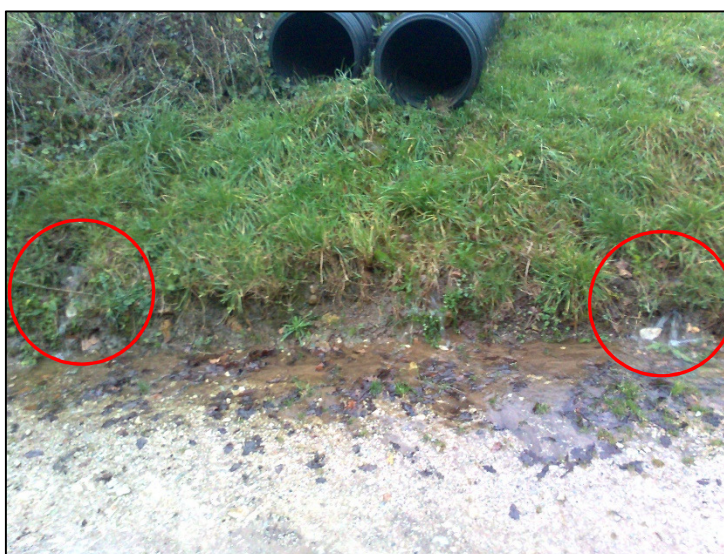
Figure 17 : Eau jaillissant du sol dans le périmètre de protection immédiat du captage
